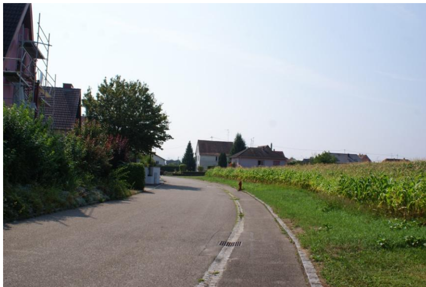
La rue du Haag : les maisons à gauche et le site à droite. Août 2015
