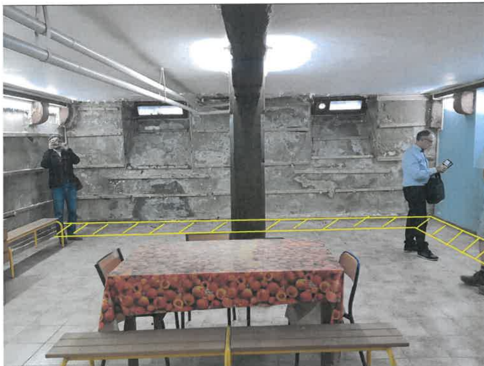
Sciage dallage béton pour libérer l'humidité emprisonnée sous le sol
