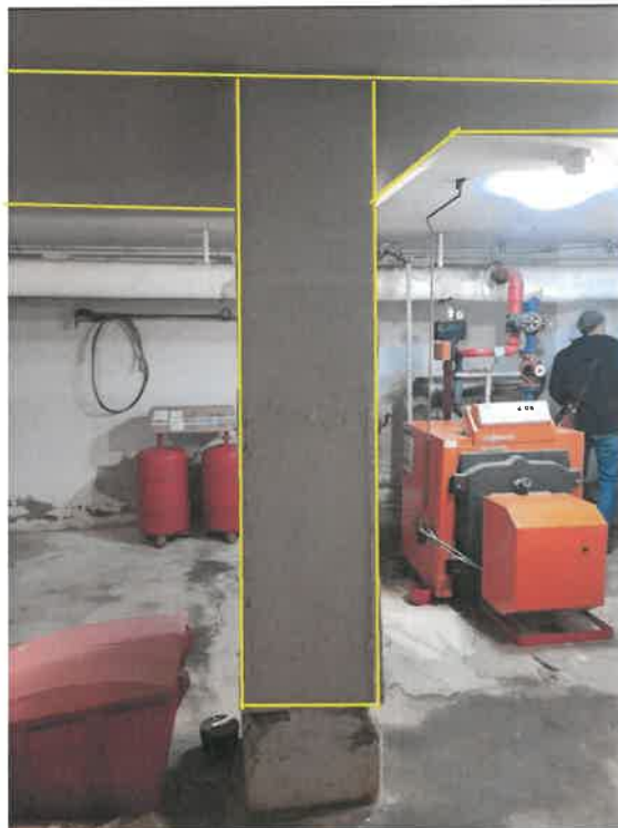
Curage du placo autour du poteau et des poutres – chaufferie sous-sol
