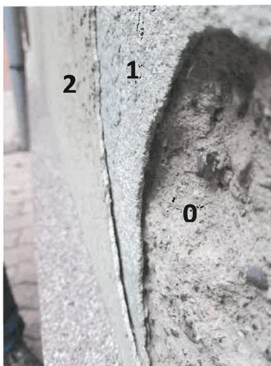
Couches d'enduit existants sur les façades
