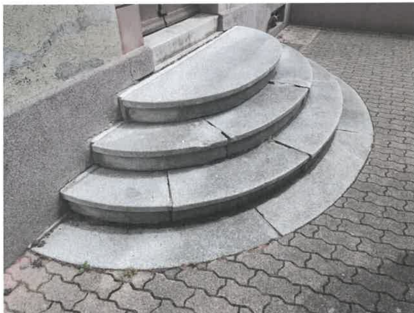
Escalier d'accès côté église
