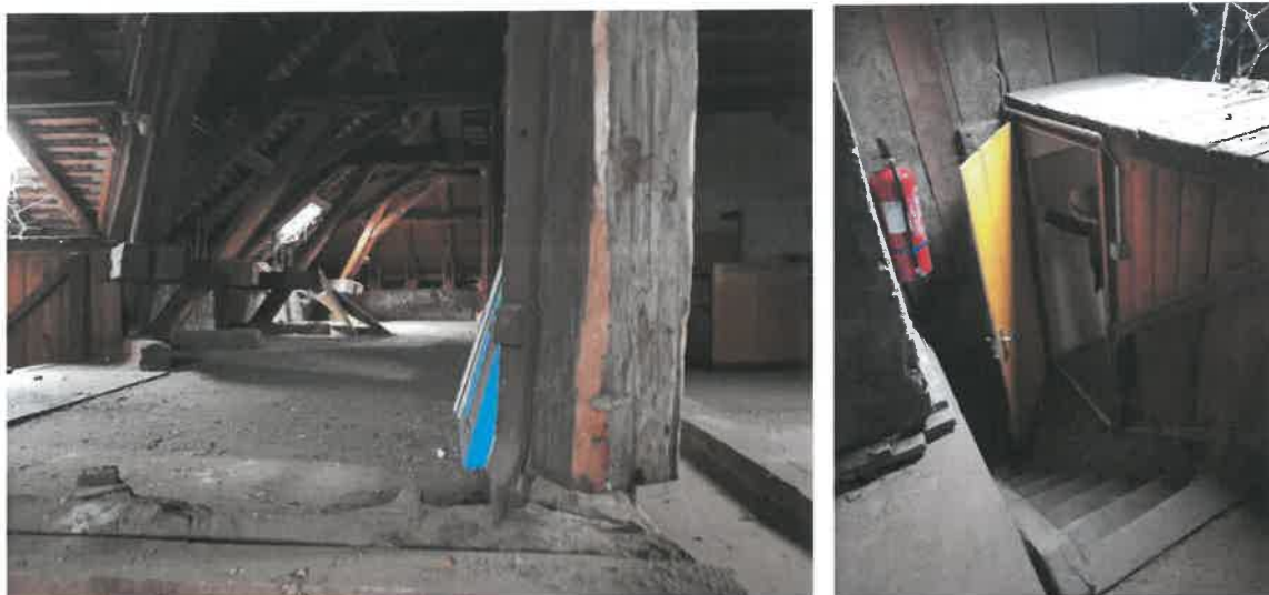
Combles existants avec isolation en ouate de cellule + plancher
