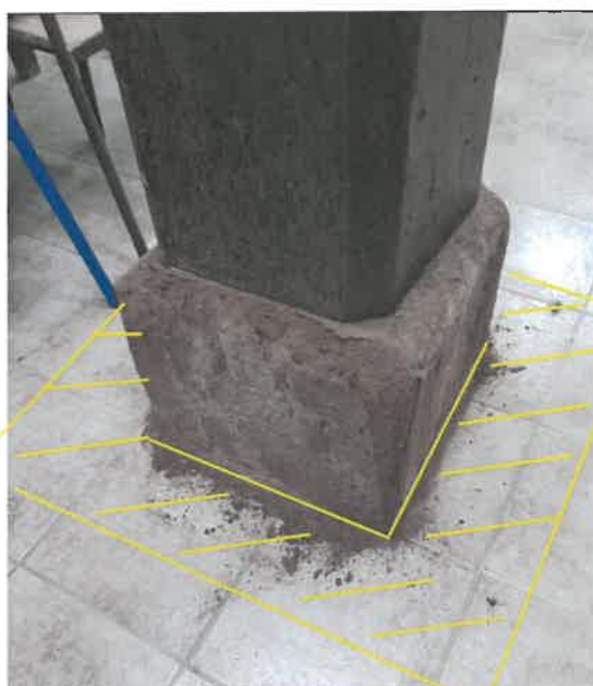
Traitement du dès en grès et sciage du dallage
